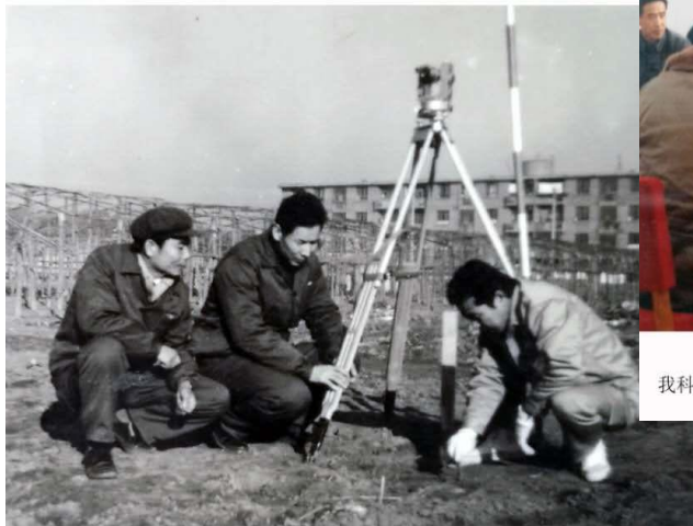
研究所是在这块空旷的土地上建设的，此前它是槐底乡农科站属地。 1979年始在此安装日中科技交流协会赠送我所的装配式镀锌钢管塑料大棚。 图为日方技术人员与我方共同进行塑料大棚安装前的勘测工作。（1979年11月）
